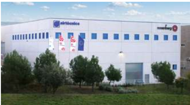
Sede central de Airtècnics en Castellar del Vallès (España)
