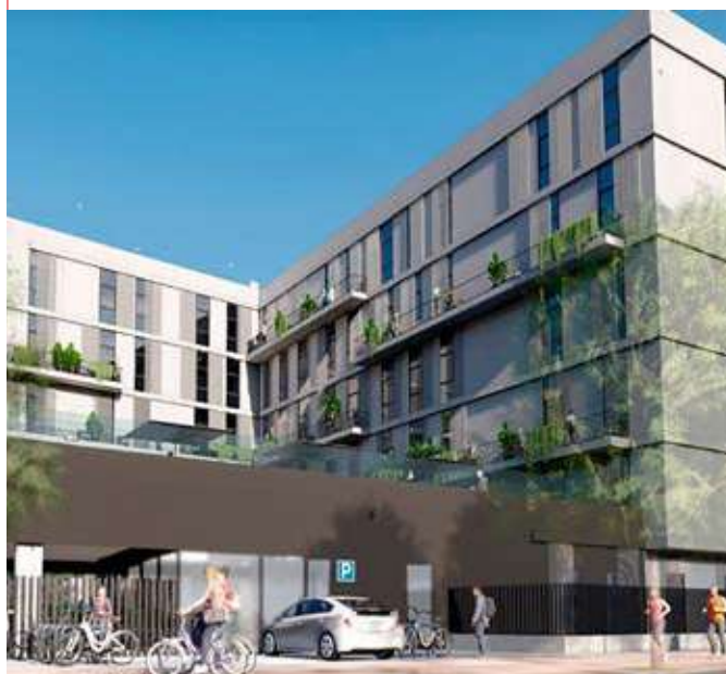
Residencia de estudiantes, Cartuja Life (Sevilla) Sistema Instalado: KXZ (VRF)
