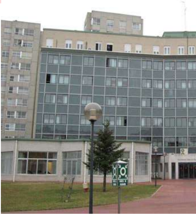
Residencia Fundación Caja Burgos (Burgos) Sistema Instalado: Q-ton Bomba de calor con CO 2 , KXZ (VRF) y Recuperadores
