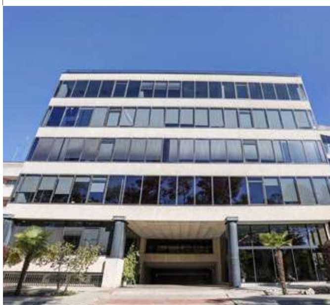
Oficinas Dr. Zamenhoff, 36 (Madrid) Sistema Instalado: KXZ (VRF)
