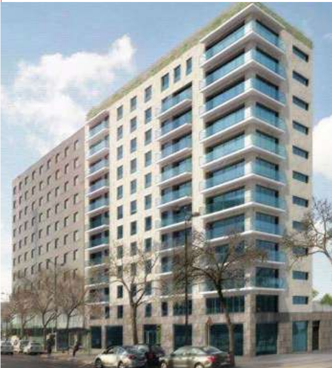
41 Viviendas, Avda. de Francia (Valencia) Sistema Instalado: Q-ton Bomba de calor con CO 2 y KXZ (VRF)
