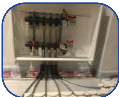
5.- Colocación tubo de los distintos circuitos.
