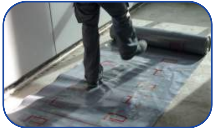
2.- Colocación hoja PE. Debe ser doble y que se eleve 5cm por la pared.
