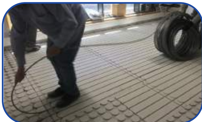
5.- Colocación tubo de los distintos circuitos.
