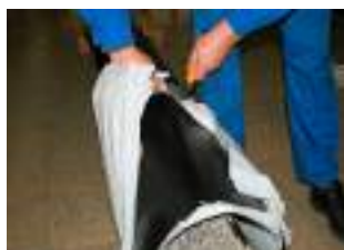
1. Una vez soldado el tubo de acero, deslizar la camisa que previamente se ha introducido en unos de los tubos.
