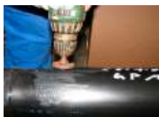
13. Repasar los orificios con una broca.
