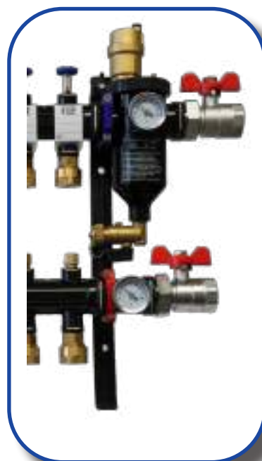
COLOCACIÓN DEL SOPORTE SOBRE LOS TERMINALES
