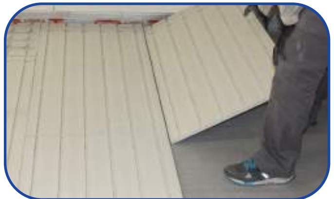
4.- Colocación de las placas con las curvas hacia la pared.
