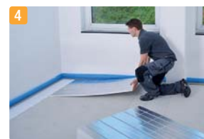
Precortes en la placa para facilitar su instalación.
