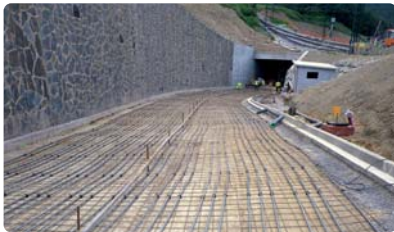
Entrada a túnel en el Pirineo.
