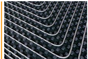
Sujeción segura del tubo con paso a múltiplos de 50 mm.
