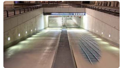
Rampa de acceso a garaje calefactada.
