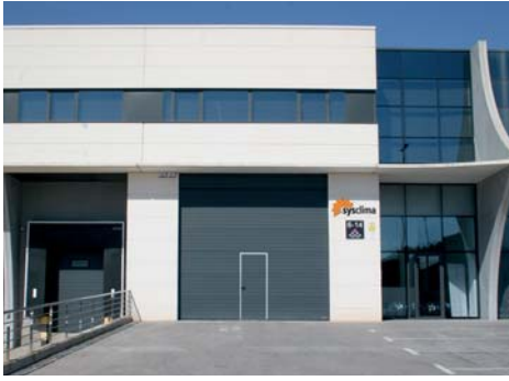
Oficinas centrales y almacén logístico. [SYSCLIMA]
