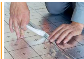
Solapa autoadhesiva con cinta protectora.
