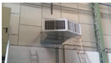
*Plenum difusor lateral de dos salidas
